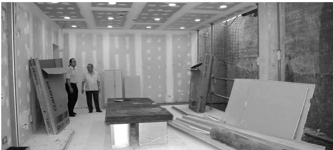
Una de les sales del soterrani primer
